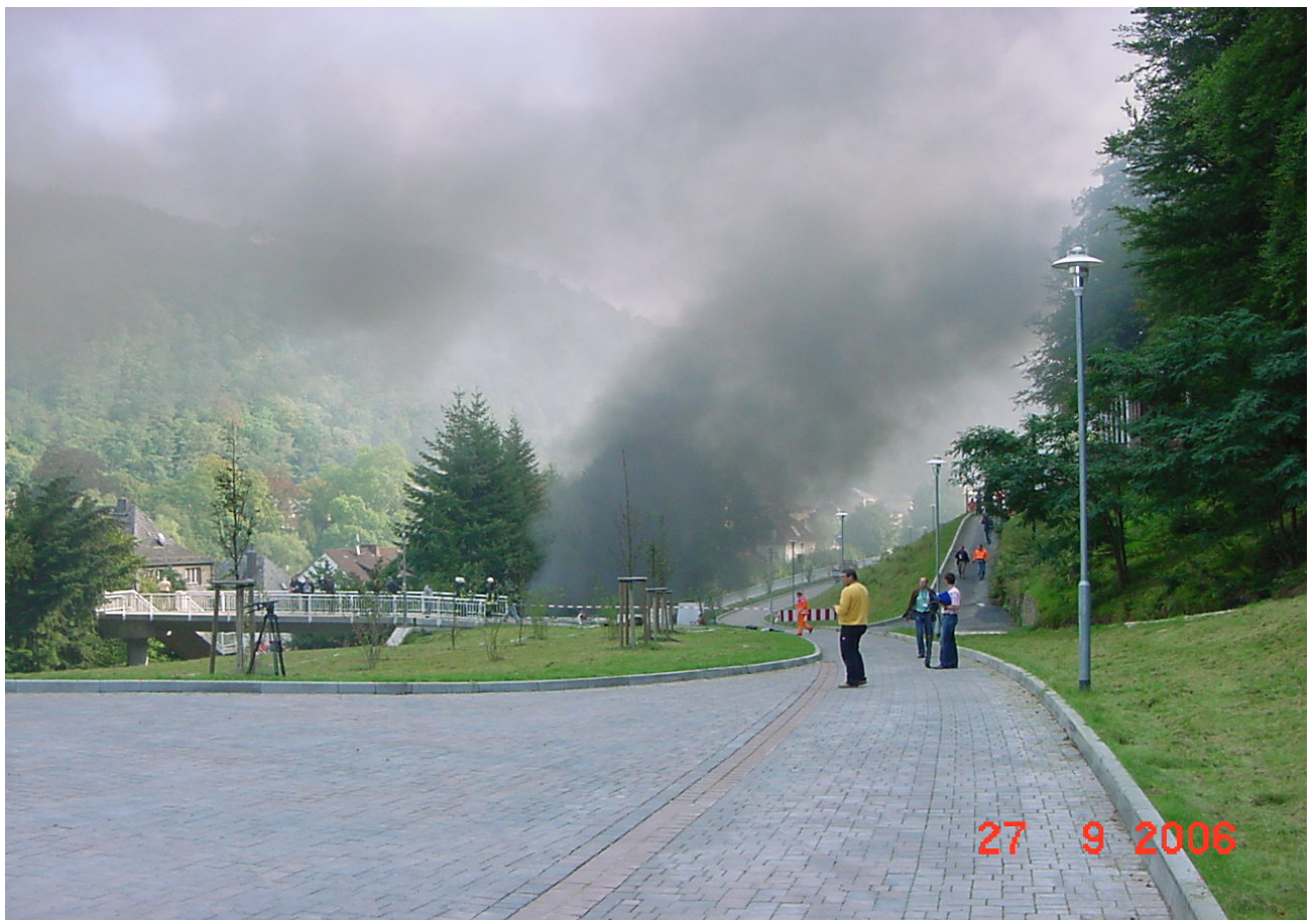
Bild 38: Rauchausbreitung an der Entrauchungsstation Nr. 06 nach 29 Minuten bei Westwind.
