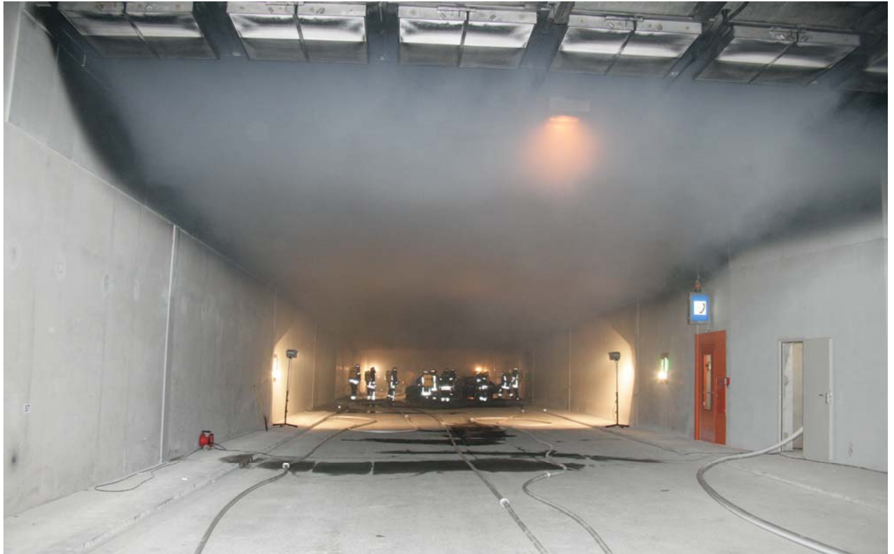
Bild 49: Stabile Schichtströmung des Wasserdampfes beim Löscheinsatz, 32 Minuten nach Brandbeginn von Westen gesehen. Die Tunnelwände waren nur in dem 1 m hohen Wandstreifen nahe der Decke vom Ruß geschwärzt, die Notrufnische mit SOS-Leuchte und die Fluchtweghinweisleuchten mit Brandnotleuchten blieben allzeit sichtbar und unversehrt und die Hydrantennische immer zugänglich.
