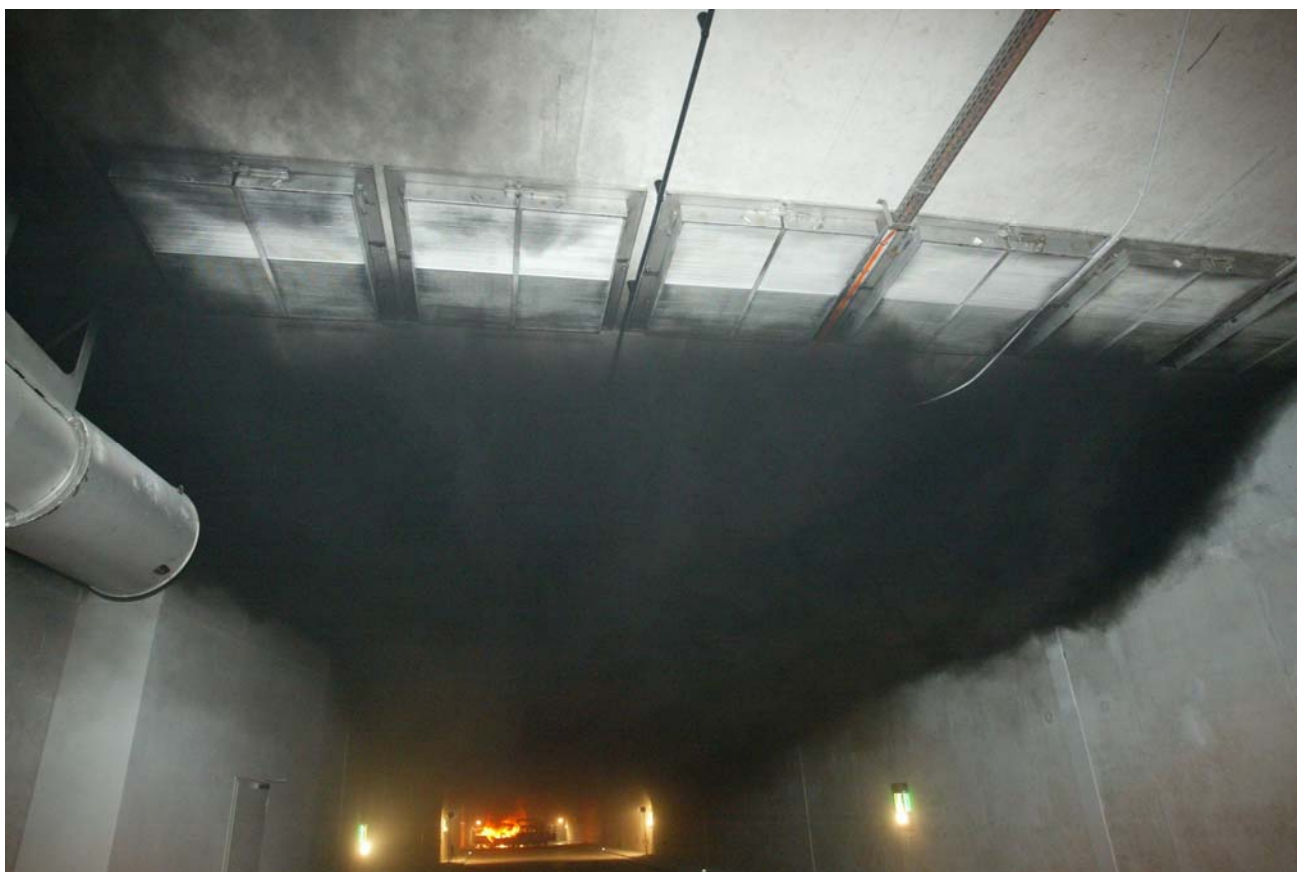
Bild 40: Stabile Rauchsichtströmung zur Entrauchungsstation Nr. 06, die Dicke der Rauchsicht beträgt ca. 1,0 m (Höhe der Hitzeschutzplatten an der Wand), der Strahlventilator bleibt rauchfrei, keine Überströmung der Absaugöffnungen und kein Raucheintrag in die Aufenthalts-, Flucht- und Rettungszonen, die Deckenleuchten und Kameras sind jedoch nicht mehr sichtbar, deshalb kein Videobild aus diesem BMA verfügbar, nach 12 Minuten von Osten gesehen.
