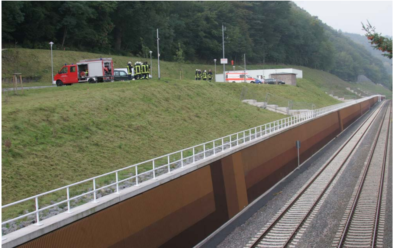
Bild 18: Lage des Betriebsgebäudes am Fuße des Malbergs (Nordhang), mit einem von sechs Flucht-treppenhäusern sowie den fünf westlich gelegenen Entrauchungsstationen, von insgesamt zwölf.
