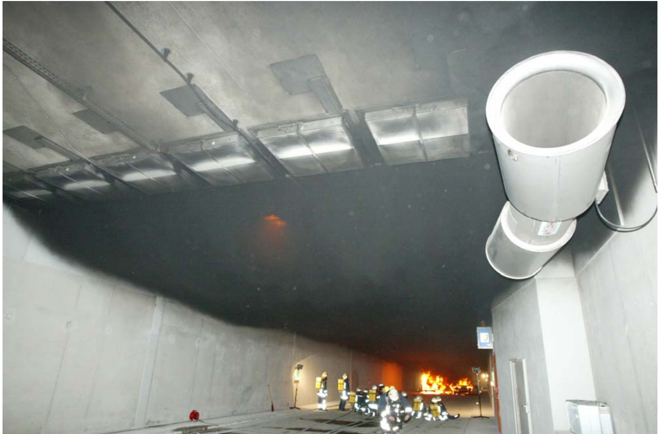
Bild 41: Stabile Rauchschichtströmung zur Entrauchungsstation Nr. 05, die Dicke der Rauchschicht beträgt ca. 1,0 m (Höhe der Hitzeschutzplatten an der Wand), der Strahlventilator bleibt rauchfrei, keine Überströmung der Absaugöffnungen und kein Raucheintrag in die Aufenthalts-, Flucht- und Rettungszonen, Deckenleuchten und Kameras sind jedoch nicht sichtbar, nach 23 Minuten von Westen gesehen.
