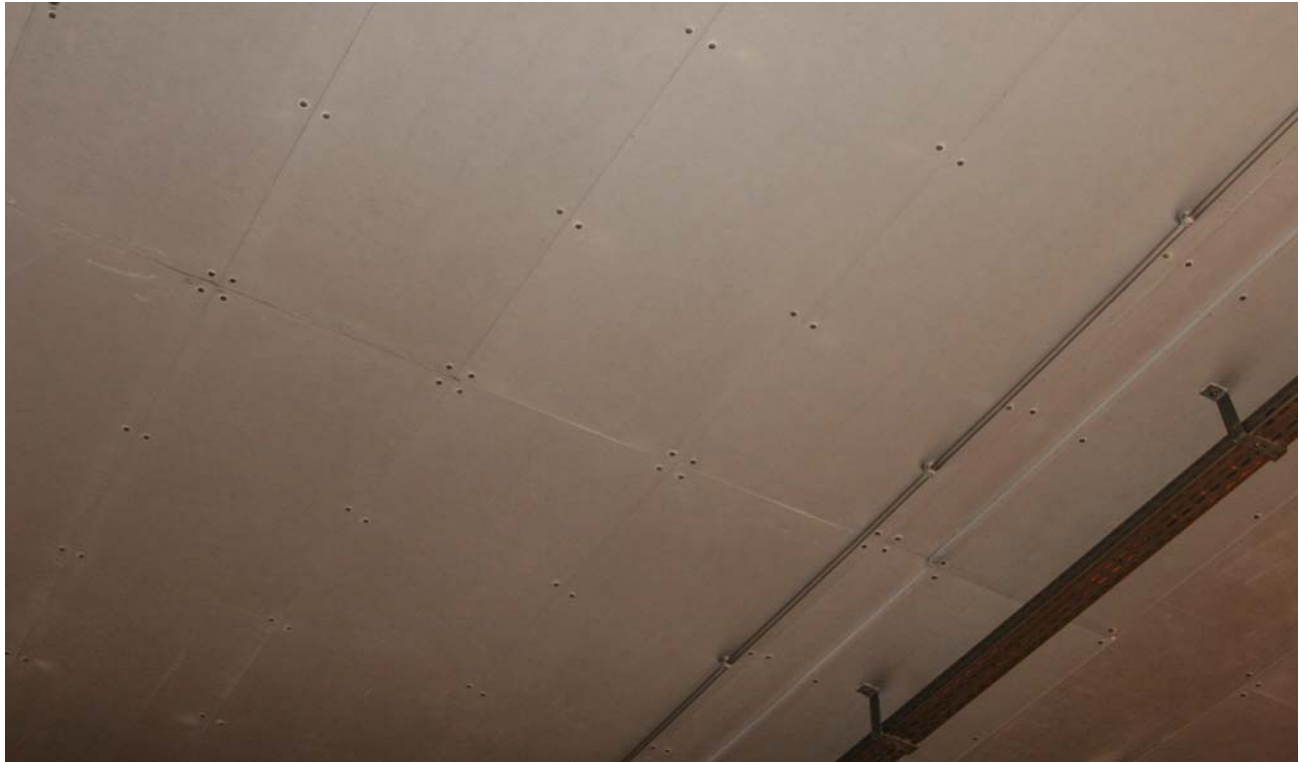
Bild 22: Verkleidung der 9,5 m breiten Tunneldecke auf 100 m mit 15 mm Brandschutzplatten. Dabei blieben das Brandsensorkabel, die Funkantenne, die Elektrokabel, Deckenleuchten, Lautsprecher, Videokameras und die Messgeräte ungeschützt (nur die Sonometer hatten Hitzeschutzgehäuse).
