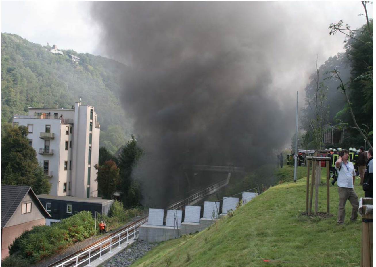
Bild 35: Rauchausbreitung an der Entrauchungsstation Nr. 05, die Rauchsäule erreichte bei wenig Windeinwirkung eine Höhe von etwa 25 m, nach 23 Minuten von Westen gesehen.
